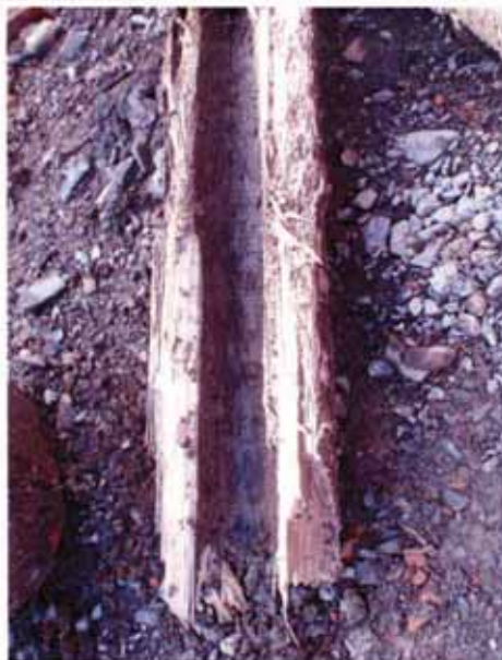
Uthulte trestokker brukt som rør ble funnet under registreringen. Disse er fra prøverute 3 på område 1.
