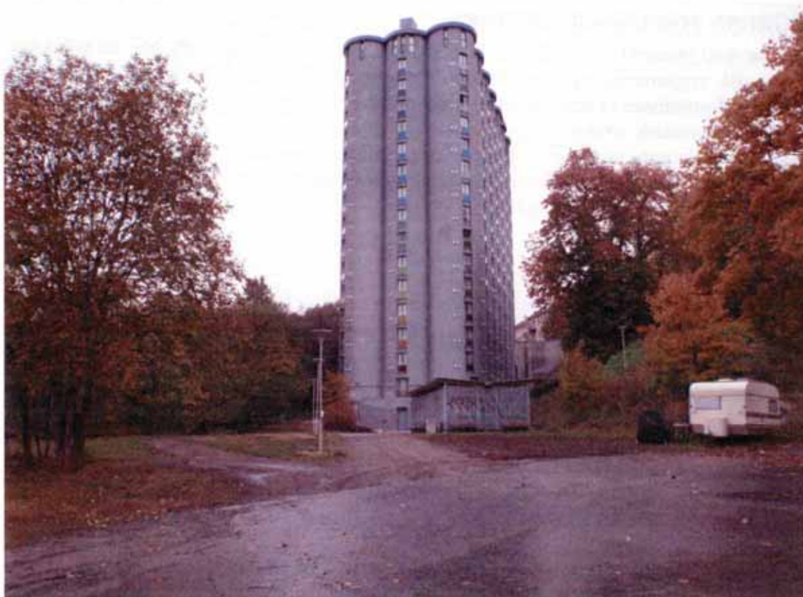
Område 2 for graving, sett mot nord.
