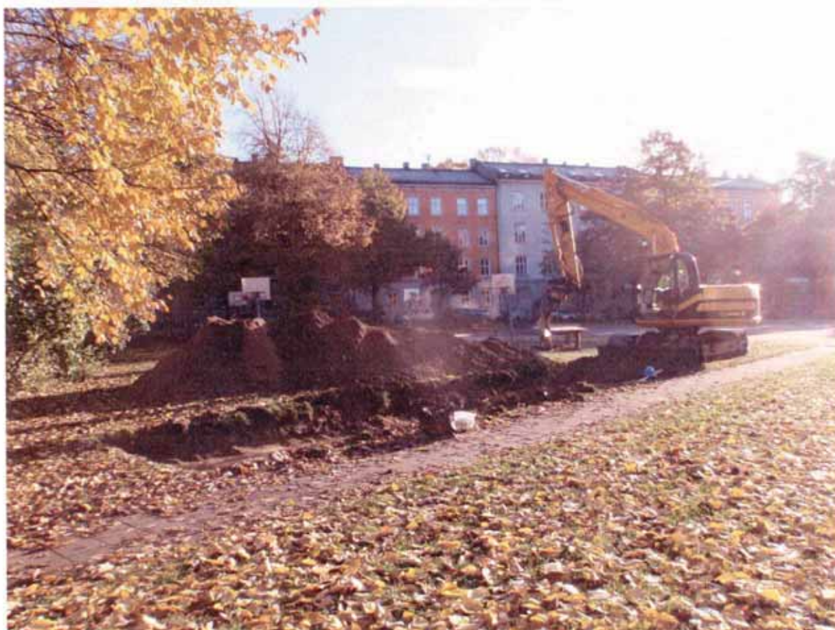
Arbeidsbilde fra sjakt 7 i område 3, sett mot øst.
