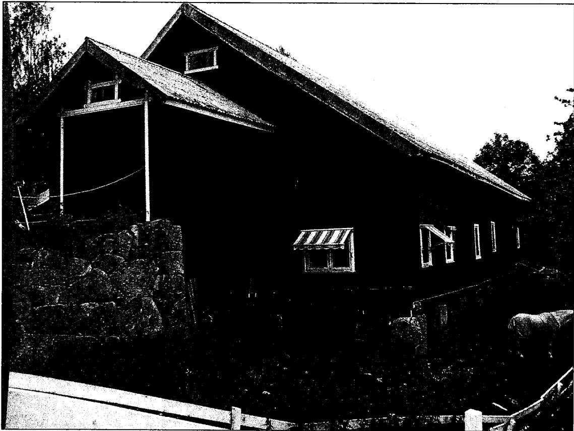
Låvens sørøstre hjørne. Låvebrua med sin flotte murkonstruksjon er bevart.
