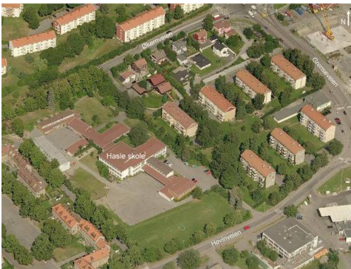
Bilde 1: Hasle skole; dagens hovedbygning ( www.gulesider.no , manipulert bilde).
