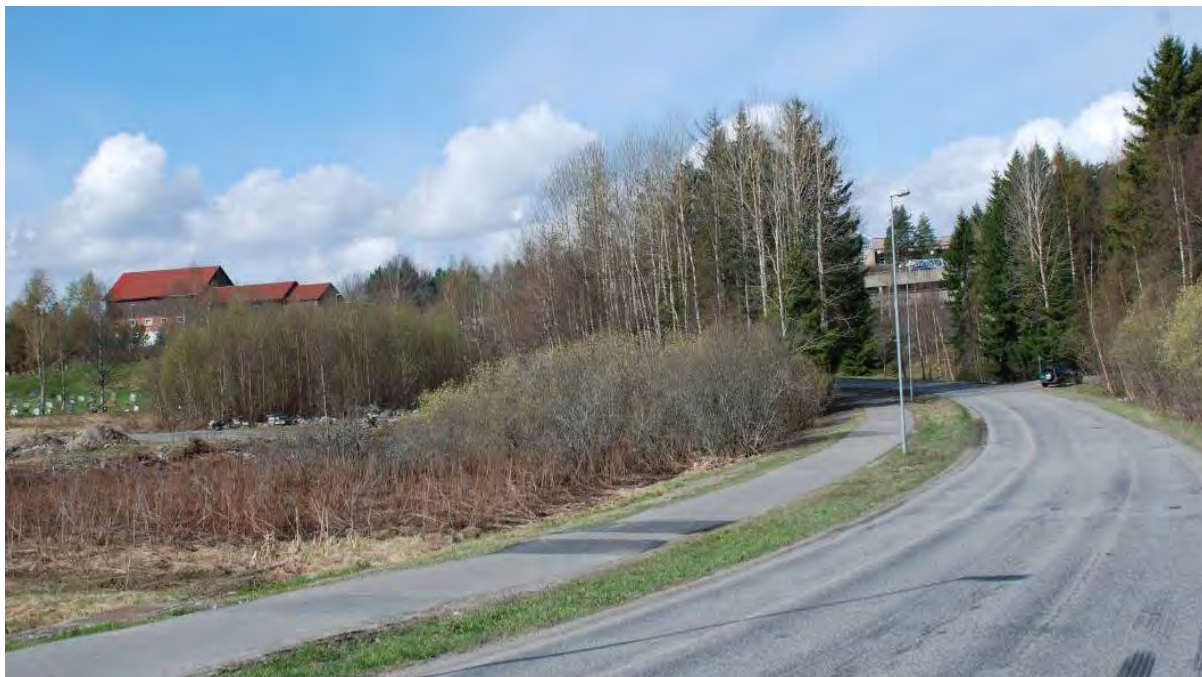
Foto viser parkeringshuset i en åpning i vegetasjonen og låvebygningen på Li gård til venstre.
