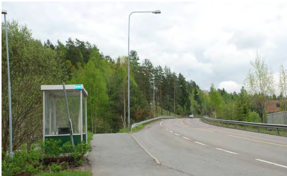
Bildet viser skråningen sett fra busstopp i Mastemyrveien.
