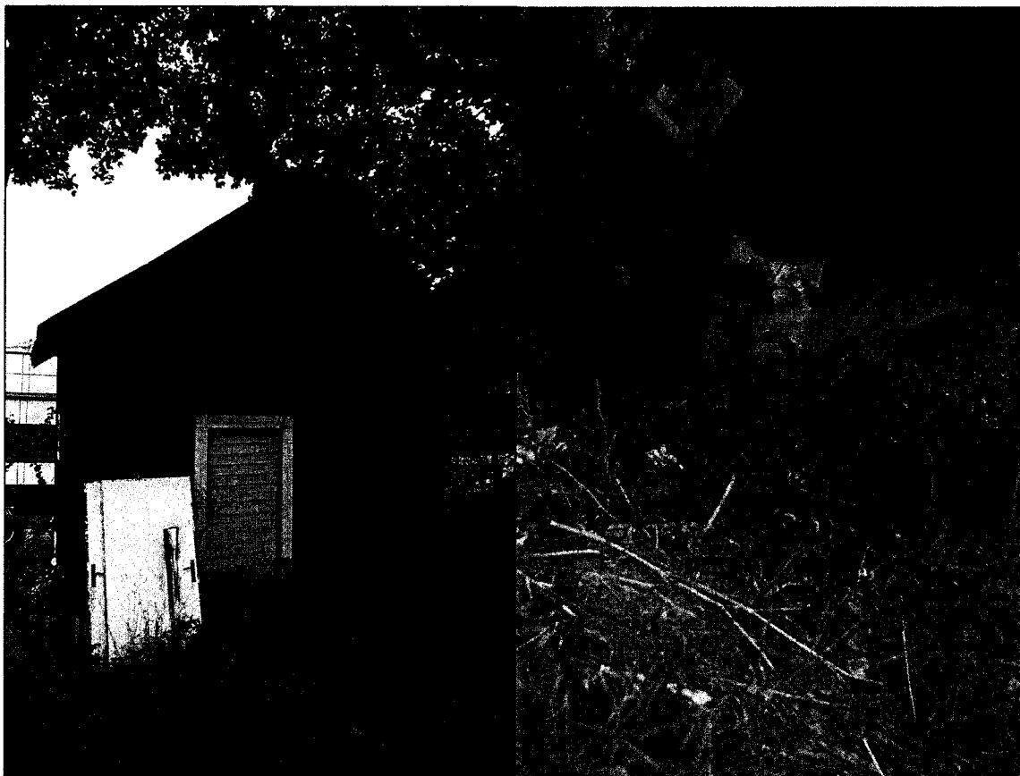
Uthuset ligger vest for hovedbygningen, og søkes bevart.
