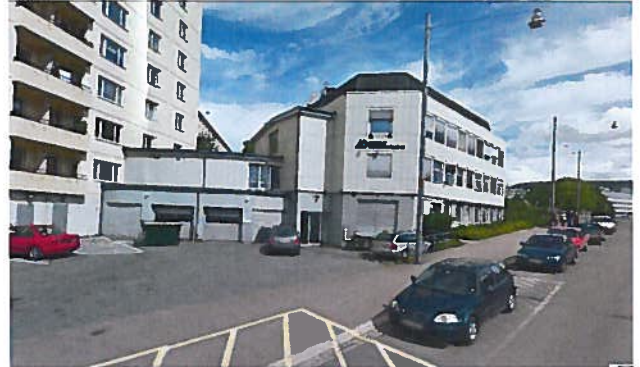
Figur 3: Byggets fasade mot sør
