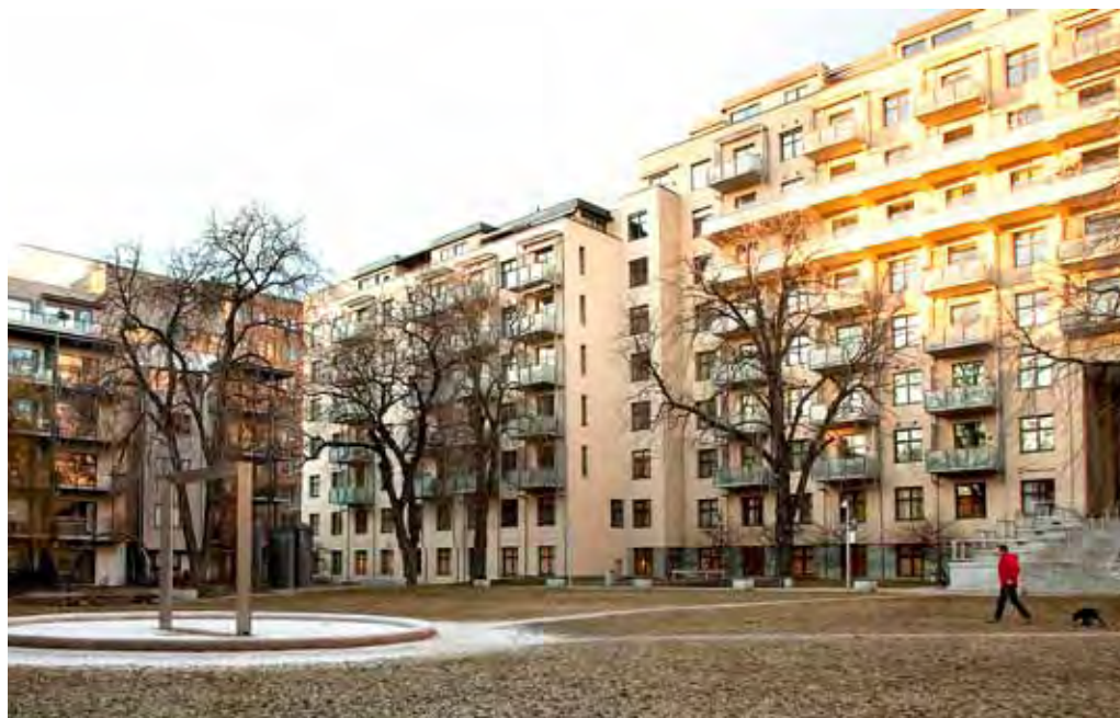
Kommuneplanarbeidet skal fastsette kvalitetskrav for byveksten. Her fra Pilestredet Park.
