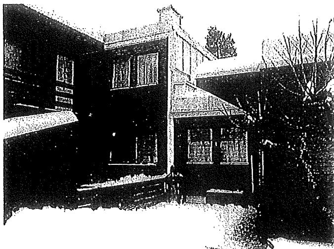
Rekkehus Type A fasade mot nord (opprinnelig fasade uten tilbygg)
