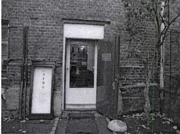
Utvidelse av åpning på inngangsdør fra 110 cm til 120 cm
