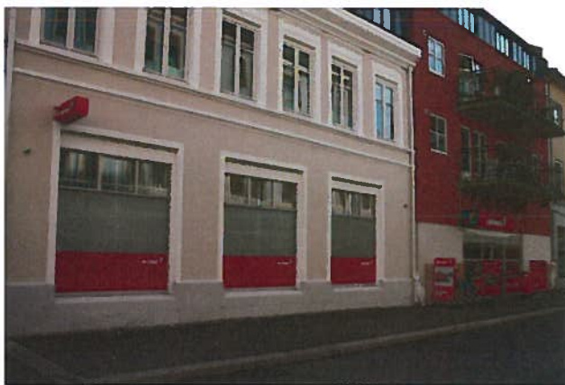
Figur 16: Rimi i Hammergata 1 (inng. Maridalsveien) (gnr/bnr 221/80). Foliering som dekker vinduene.
