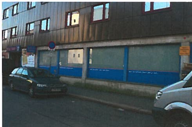
Figur 23: Rema i Mogata 12 C (gnr/bnr 221/247). Foliering som dekker vinduene.
