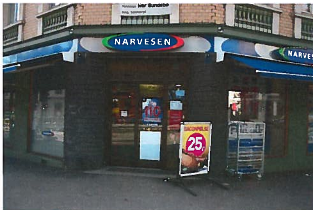
Figur 3 og 4: Narvesen i Torshovgata 6 A-D (inng. Vogts gate) (gnr/bnr 225/293). Foliering og store skilt som dekker vinduene.
