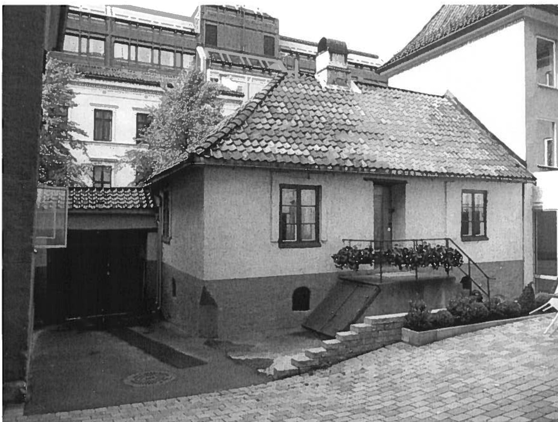
Nordfasade mot gårdsrommet og hotellet
