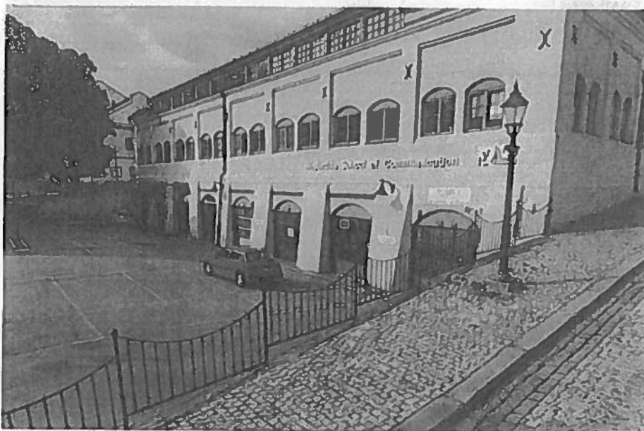
Figur 2 Fredensborgveien 24. Fasade mot Fredensborgveien.
