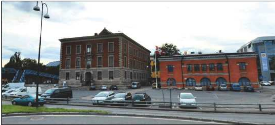
Tollbodene mot sjøsiden / Langkaigata. Dagens situasjon.
