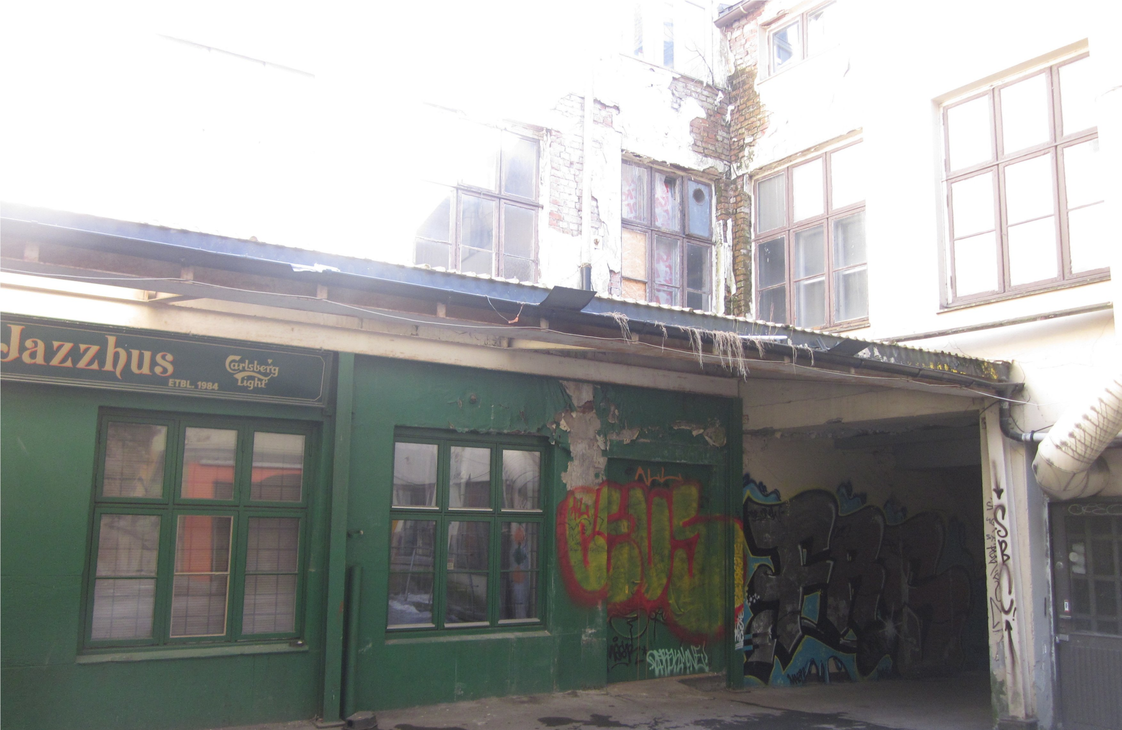
CHOKOLADEFABRIKKEN - SUPPLERING RAMMESØKNAD VEDLEGG Q1 EKSISTERENDE FASADE MOT GARDSROM
