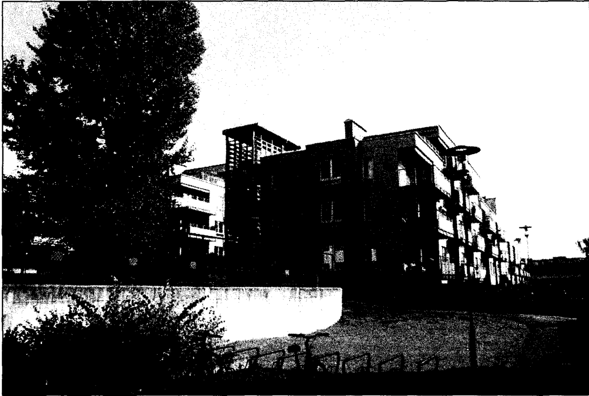
Muren mellom Sinsenveien 41 og 37 med bygget i Lørenparken Boligsameiet (øst for planområdet) sett fra vest.
