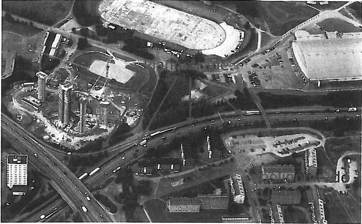
Figur 3: Skråfoto eksisterende situasjon
