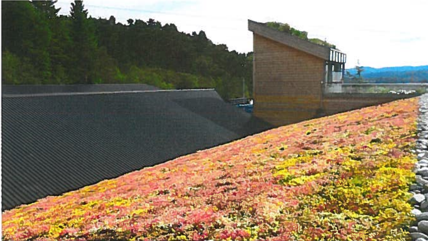
Figur 3: Ekstensivt tak på kontorbygget til Svein Boasson AS i Bergen
