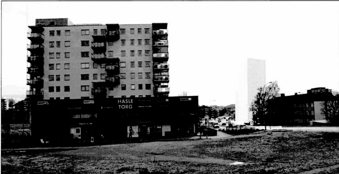
Figur 6.6 Fjernvirkning, tiltaket sett fra krysset Grenseveien / Økernveien
