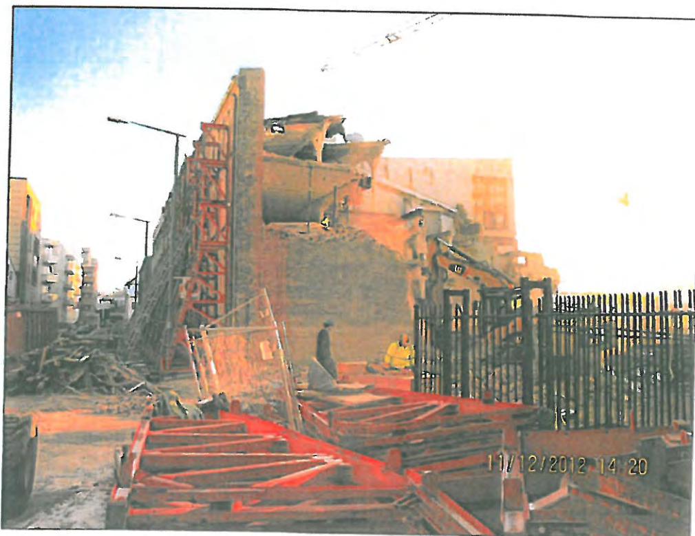
Bilde 01. Bildet viser at felt 1 og 2 i riveplan datert 16.10.12 er revet. Felt 3 er under riving. Merk gavlvegg som står igjen og holder fasaden mot Marstrandgata.
