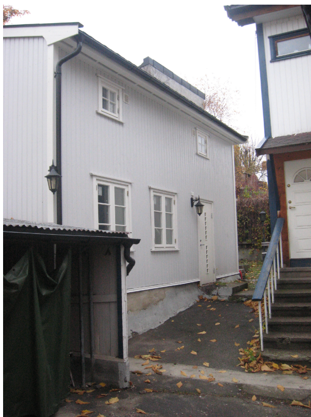
Bildet viser utforming av sperrendene ved røstet.
