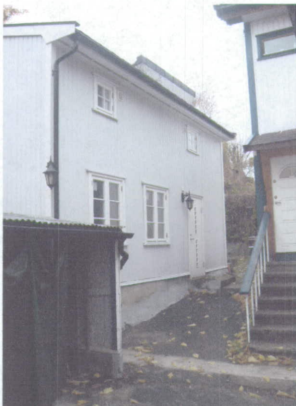
Bildet viser utforming av sperrendene ved røstet.
