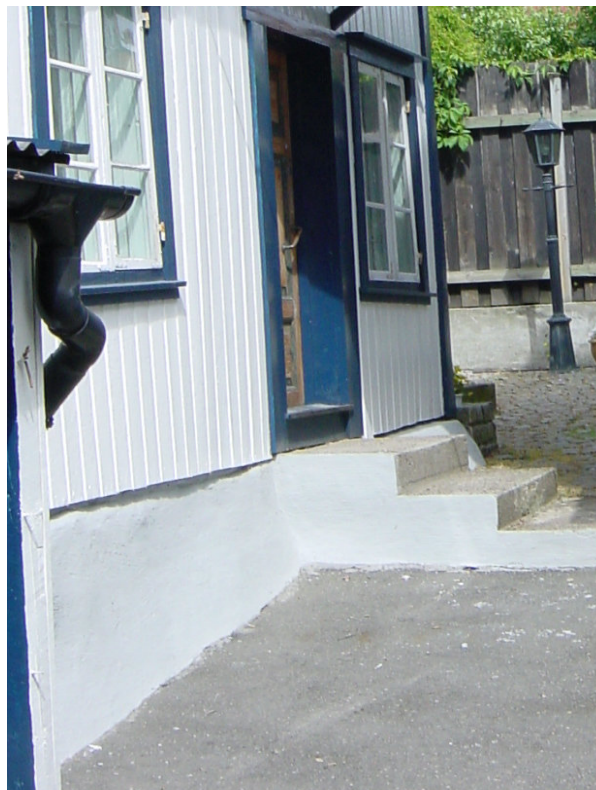
Overgang panel mot grunnmur tidligere foto 4
