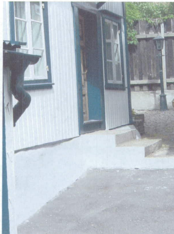
Overgang panel mot grunnmur tidligere foto 4
