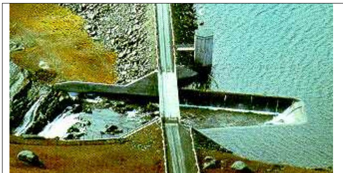
Figur 31 Eksempel på utvidelse av flomløp av typen "andenebb".
