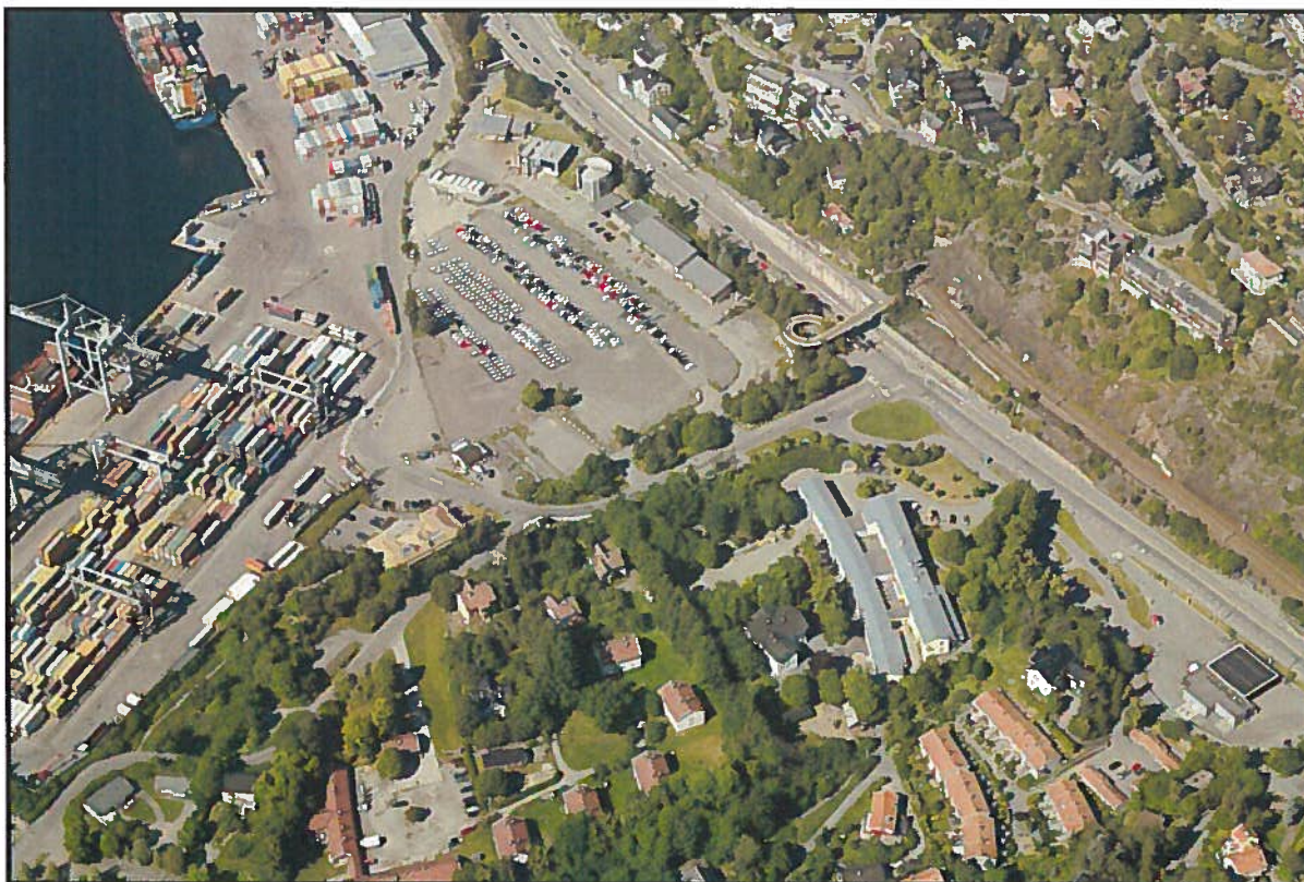
Flyfoto fra Bekkelaget, som viser bl.a. krysset mellom Mosseveien og Ormsundveien. Renseanleggets fjellanlegg har atkomst øverst i bildet, under Mosseveien og videre inn i fjellet. På utsiden ligger kun adm.bygg og gasstank. Deler av områdene på utsiden er planlagt brukt som midl anleggsområde for bygging av Midgardsormen og utvidelse av renseanlegget.
