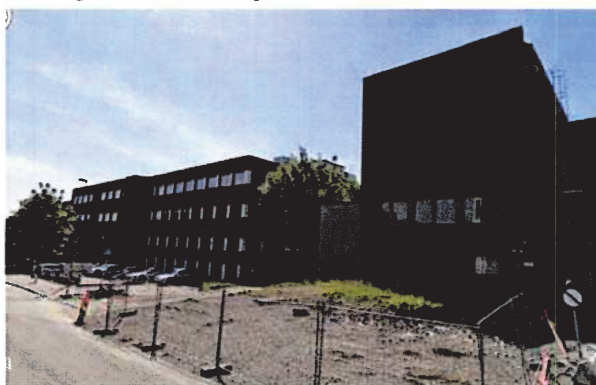
Lorenveien 51 med tiliggende trafostasjon i øst
