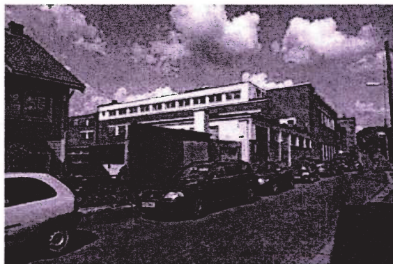
Fjellgata fra sør. Rekkehusbebyggelse i Fjellgata 28 til venstre i bildet.
