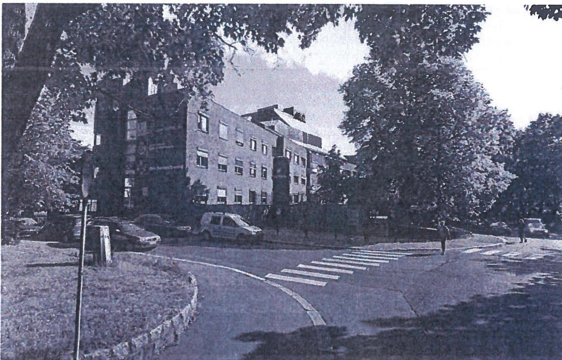
Figur 4 Fra krysset bergstien/ Akersbakken sett mot øst
