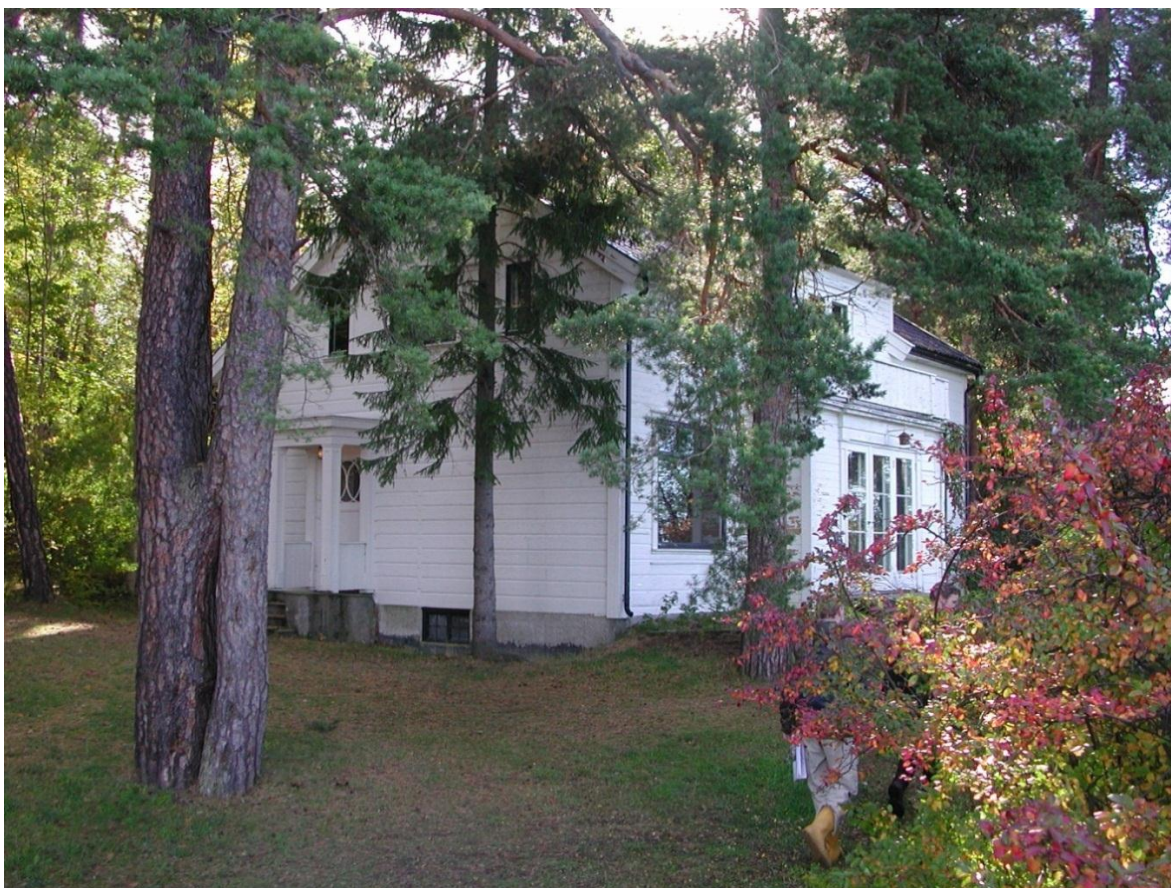
Villa Gjød i dag. Fasade nord (sett fra atkomst fra brygga). Foto: Bjørn Anders Fredriksen, UMB.
