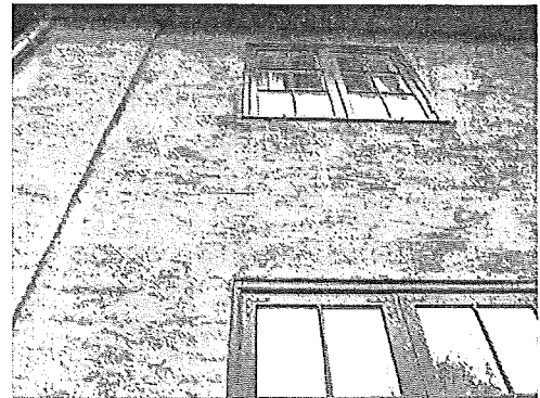
Kalkpuss og sidehengsla brunmalte vinduer
