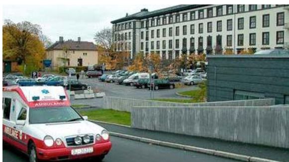
Lovisenberg sykehus, hovedfasade mot forplass
