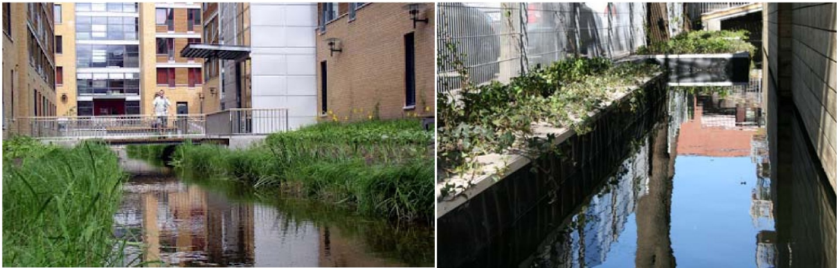
Fordrøyningskanal ved Bjølsen studentby (tegnet av Snøhetta) og åpen overvannshåndtering i Christian Krohsgate (tegnet av Dronninga landskap)
