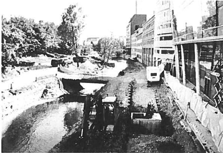
Det er plass til en gangvei på vestsida av elva etter at Midgardsormen er gravd ned. Bildet er tatt fra Hausmanns bru mot Vaterland.
