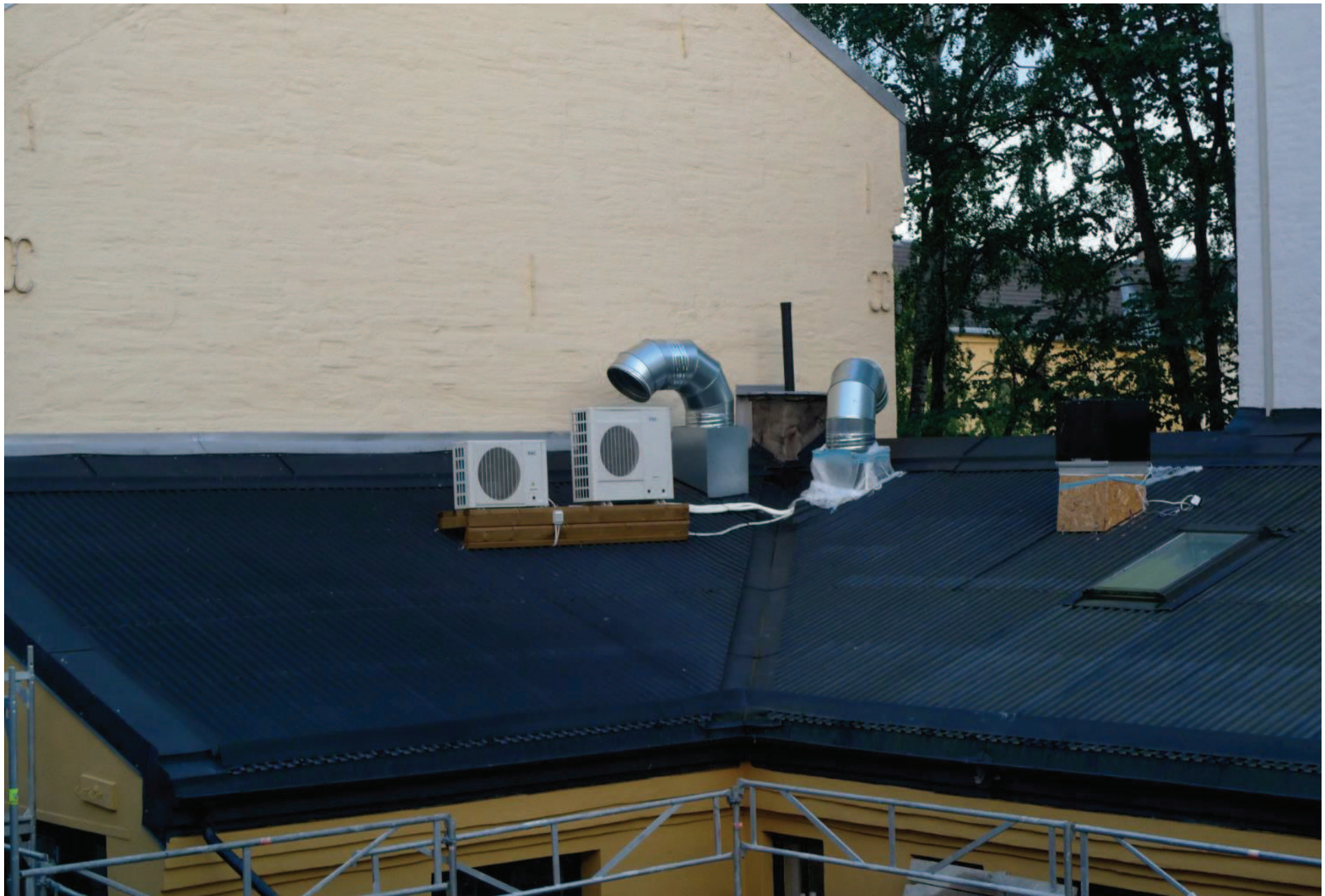
Utsiktsbilde til Korsgt 35 mot sydøst fra sørvendt balkong i 3 etg i Sameiet Markveien 56
