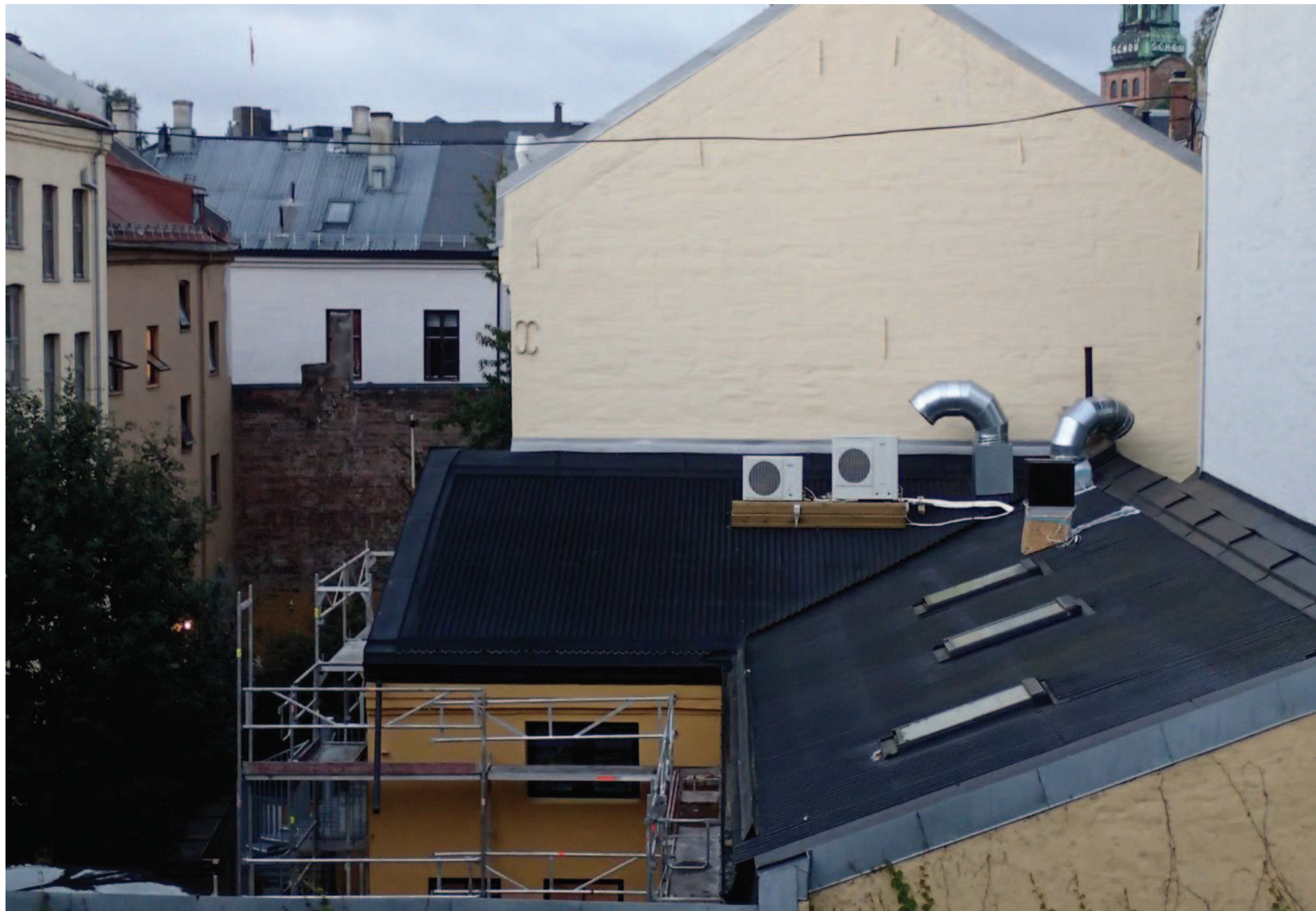
Utsiktsbilde til Korsgt 35 mot øst fra østvendt balkong i 4 etg i Sameiet Markveien 56
