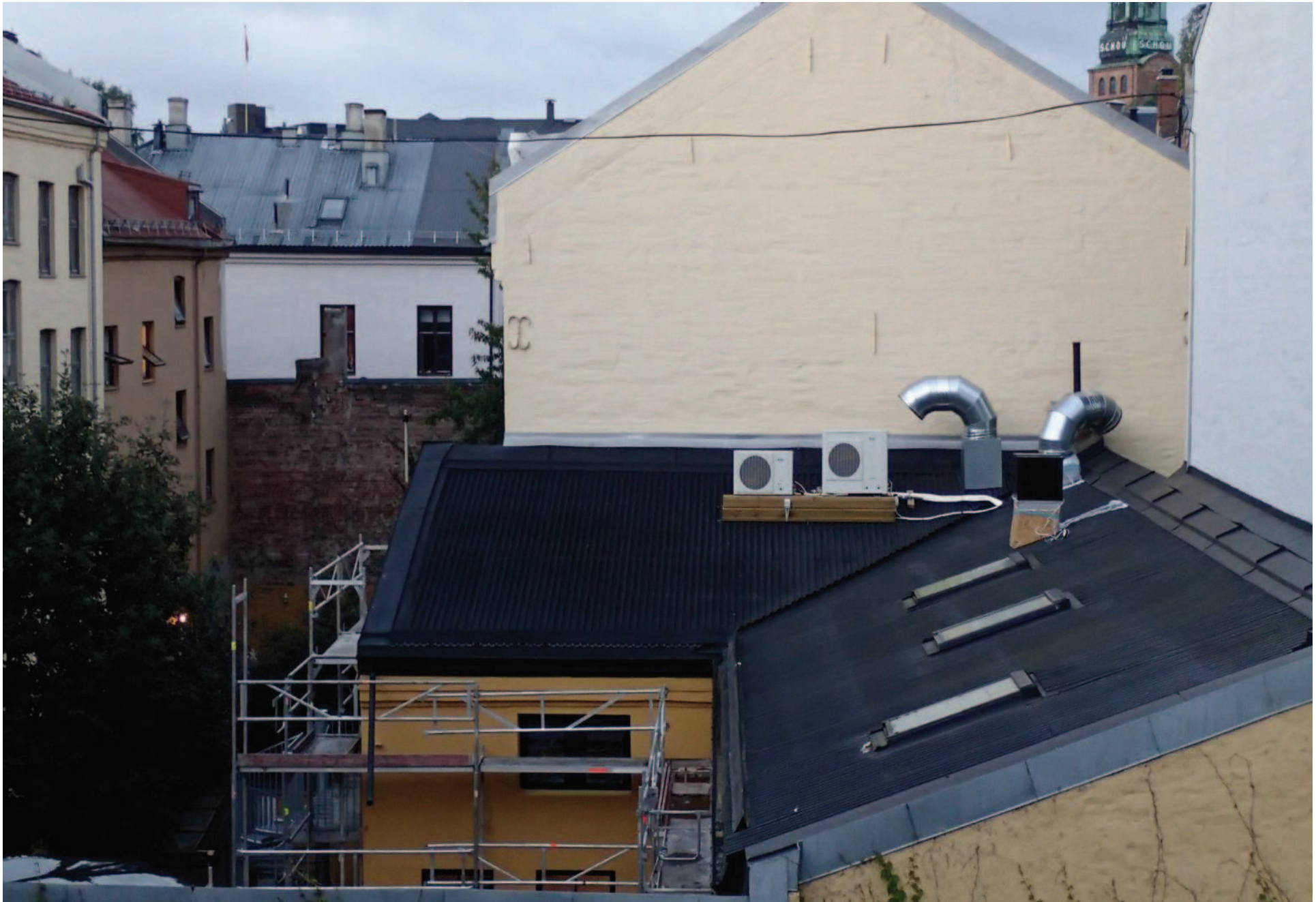
Utsiktsbilde til Korsgt 35 mot øst fra østvendt balkong i 4 etg i Sameiet Markveien 56
