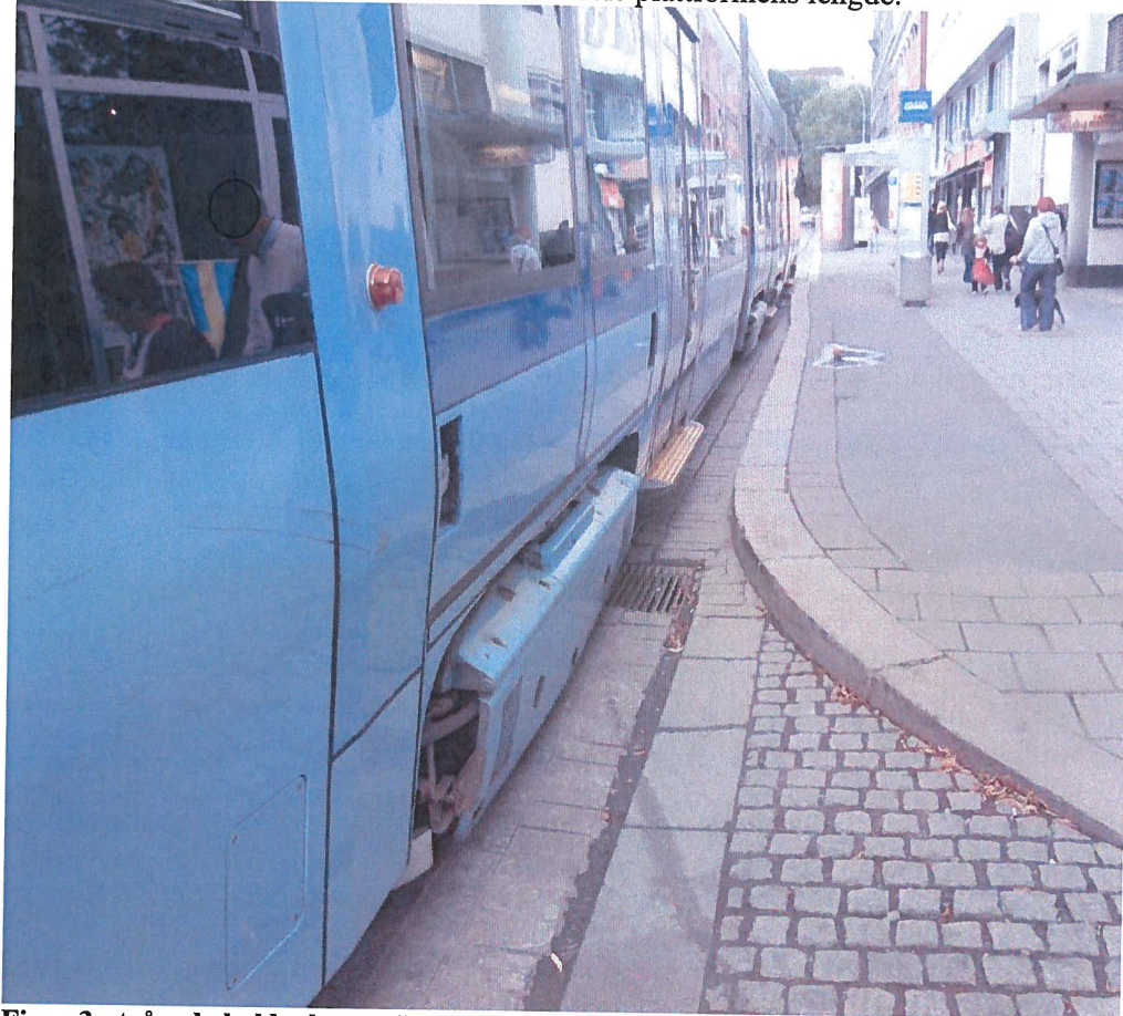
Figur 3 utgående holdeplass er ikke universelt utformet (se avstand mellom trikk og fortau)
