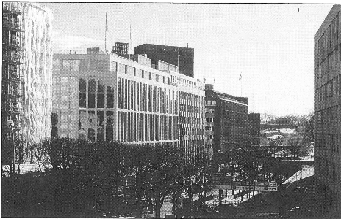
Eksisterende situasjon sett fra Vika terrassen
