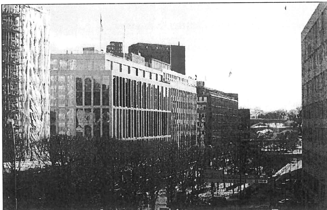
Eksisterende situasjon sett fra Vika terrassen
