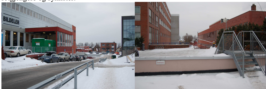
1 Ensiktig fortau og eksempel på parkering, fysiske hindre og forsøk på avbøtende tiltak for fotgjengere
