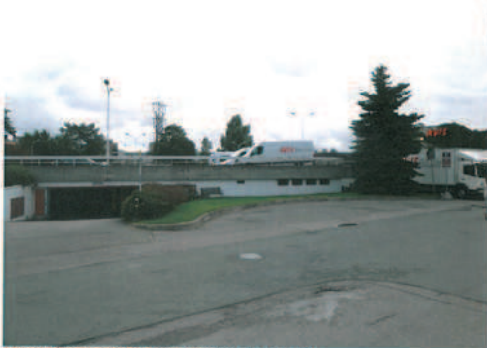
Parkeringshus nord på tomten (sett mot nordøst)
