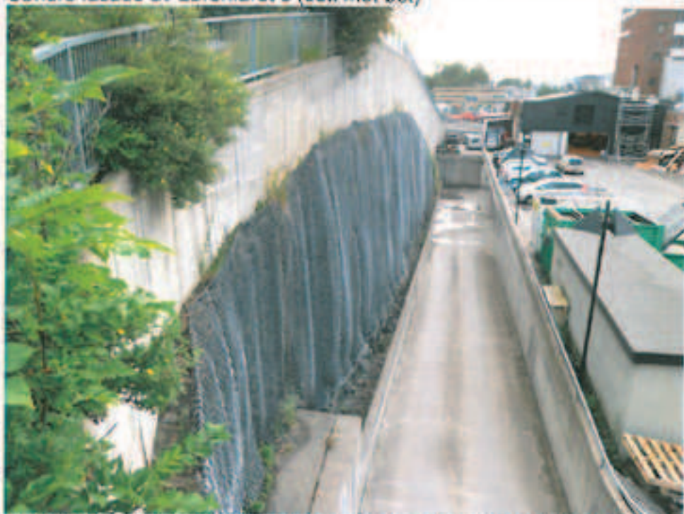
Bergskjæring langs eiendomsgrensen mellom Lørenfare 1B og Lørenveien 68 (sett mot øst)
