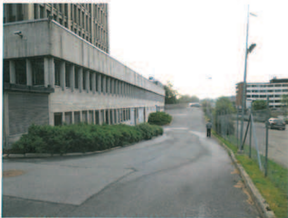
Søndre fasade av Lørenfare 3 (sett mot øst)
