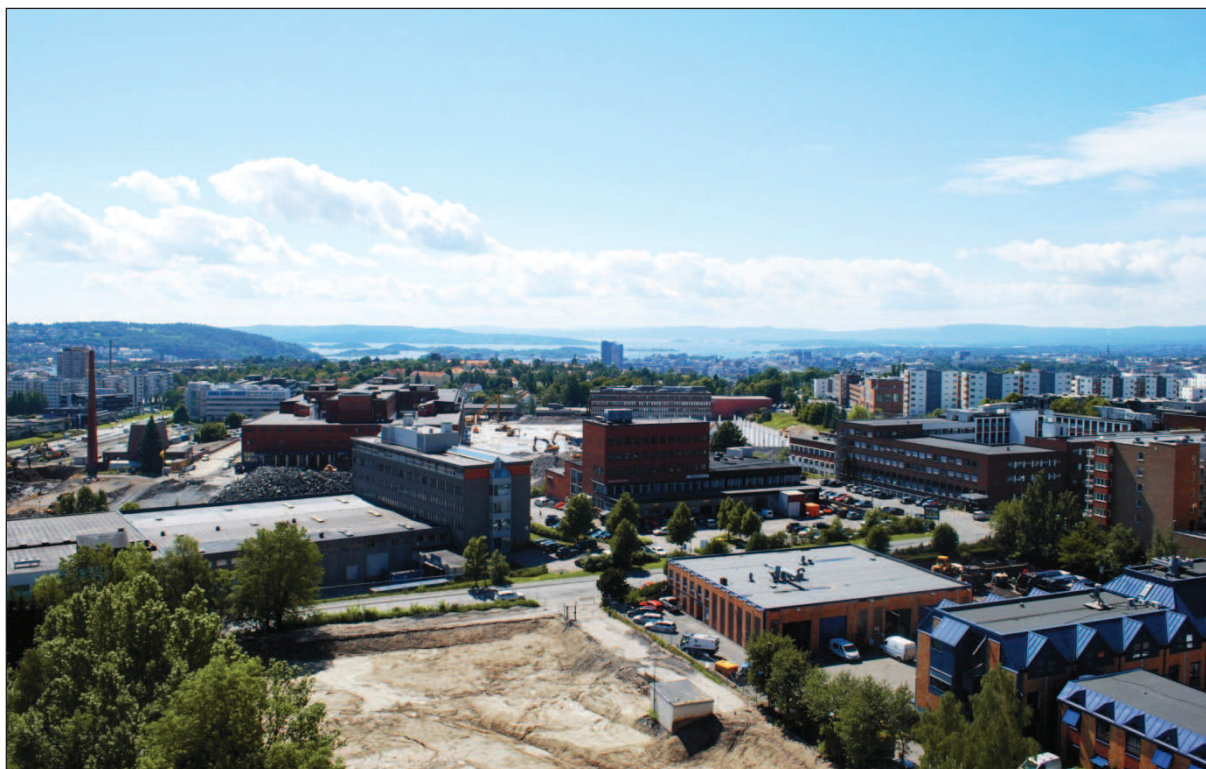
Fig. 45: Utsikt mot sør-vest fra takterrasse på Lørenfare 3
