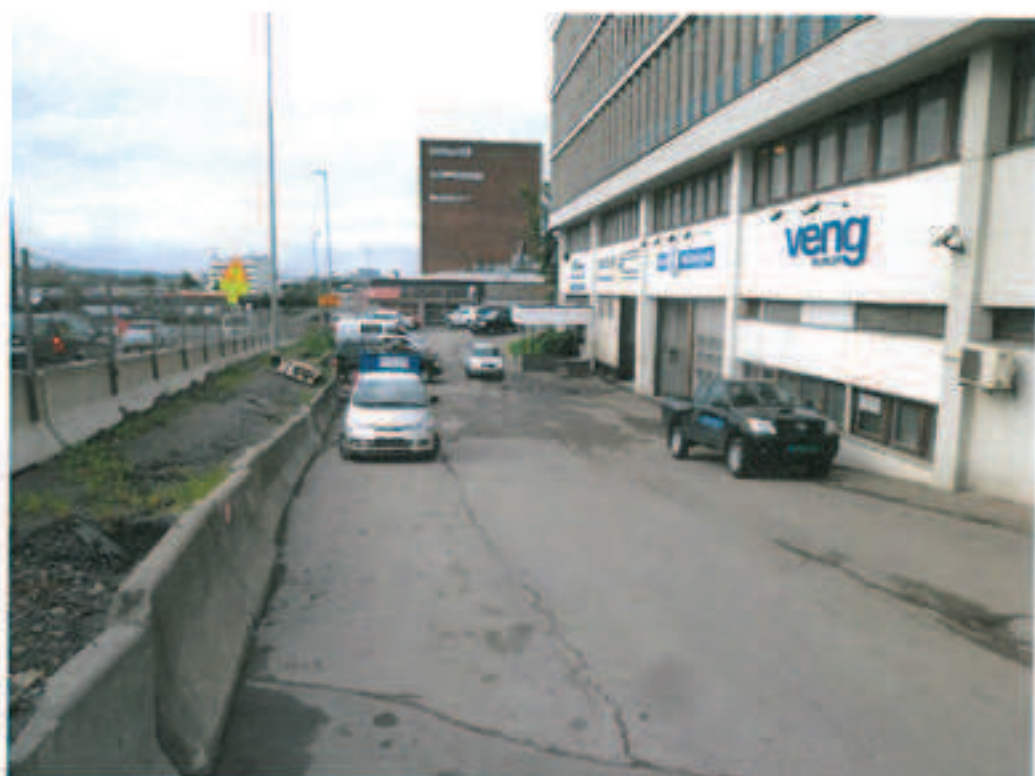
Østre fasade av Lørenfaret 1B (sett mot syd)
