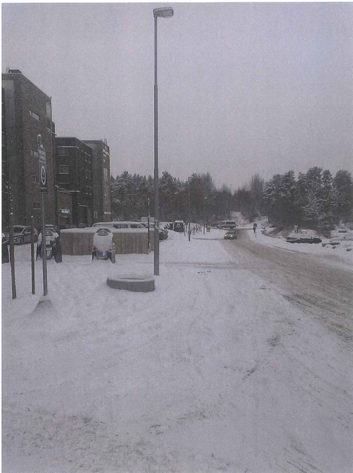
Fortsatt byggeaktivitet. Helga Vaneks vei i retning Mortensrudveien. Veien betjener Mortensrud kirke, Mortensrud Torg med nye boliger og handels- og servicetilbud. På østsiden av veien bygges det distriktpsykiatrisk sykehus og katolsk senter er på planleggingsstadiet.
