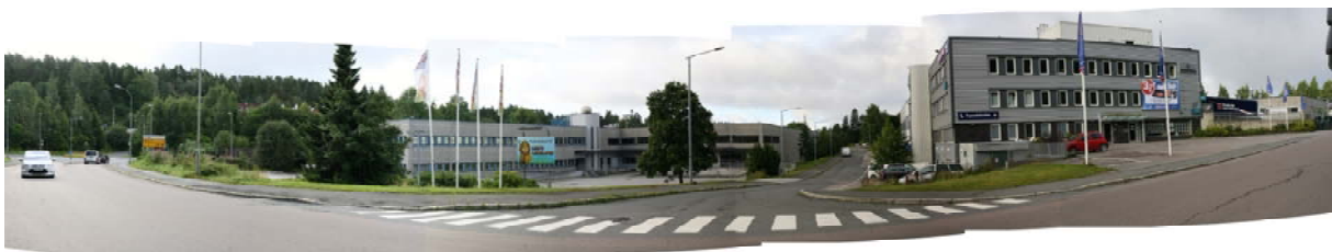
Sett fra nord inn John G Mattesons vei
