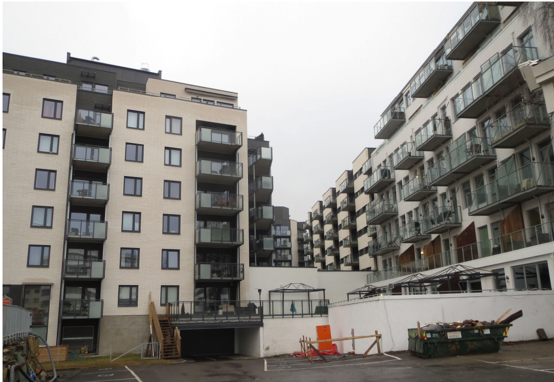
Figur 10: Torshov torg, sett fra planområdet mot nordøst
