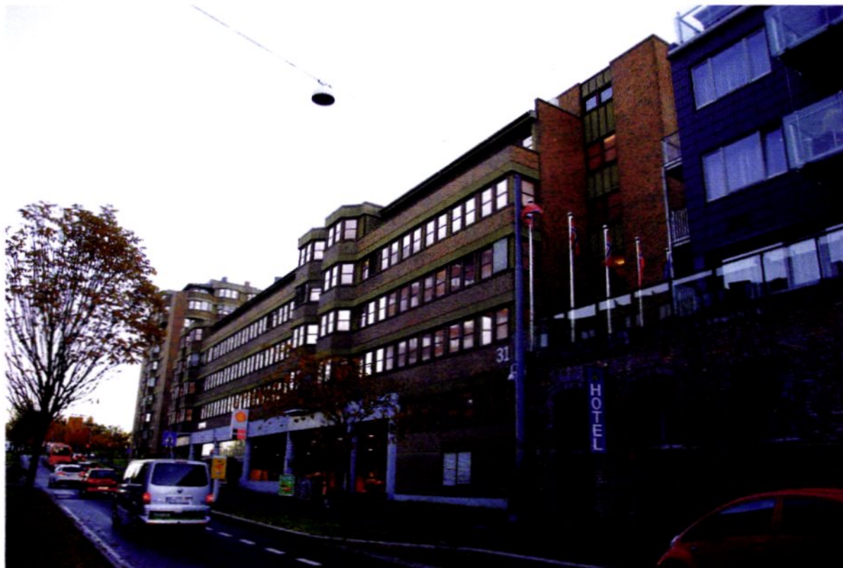
Eksisterende situasjon sett fra Kjøberggata
