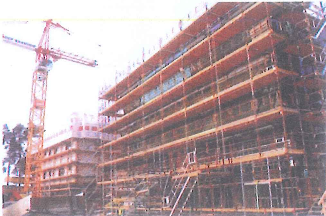
Ettersom bygget vokser fra vest til øst var det mulig å se flere stadier i byggeprosessen under befaringen.
