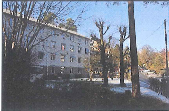
Foto sett fra sydøstre del av tomta
