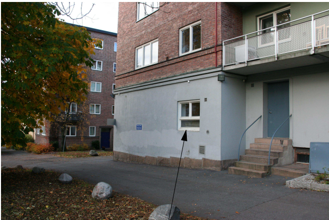
Vindu skiftes til tofagsvindu som i etasjen over.
