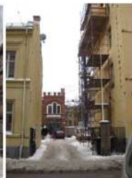
Passasje mellom Nordre gate 25 og 27
