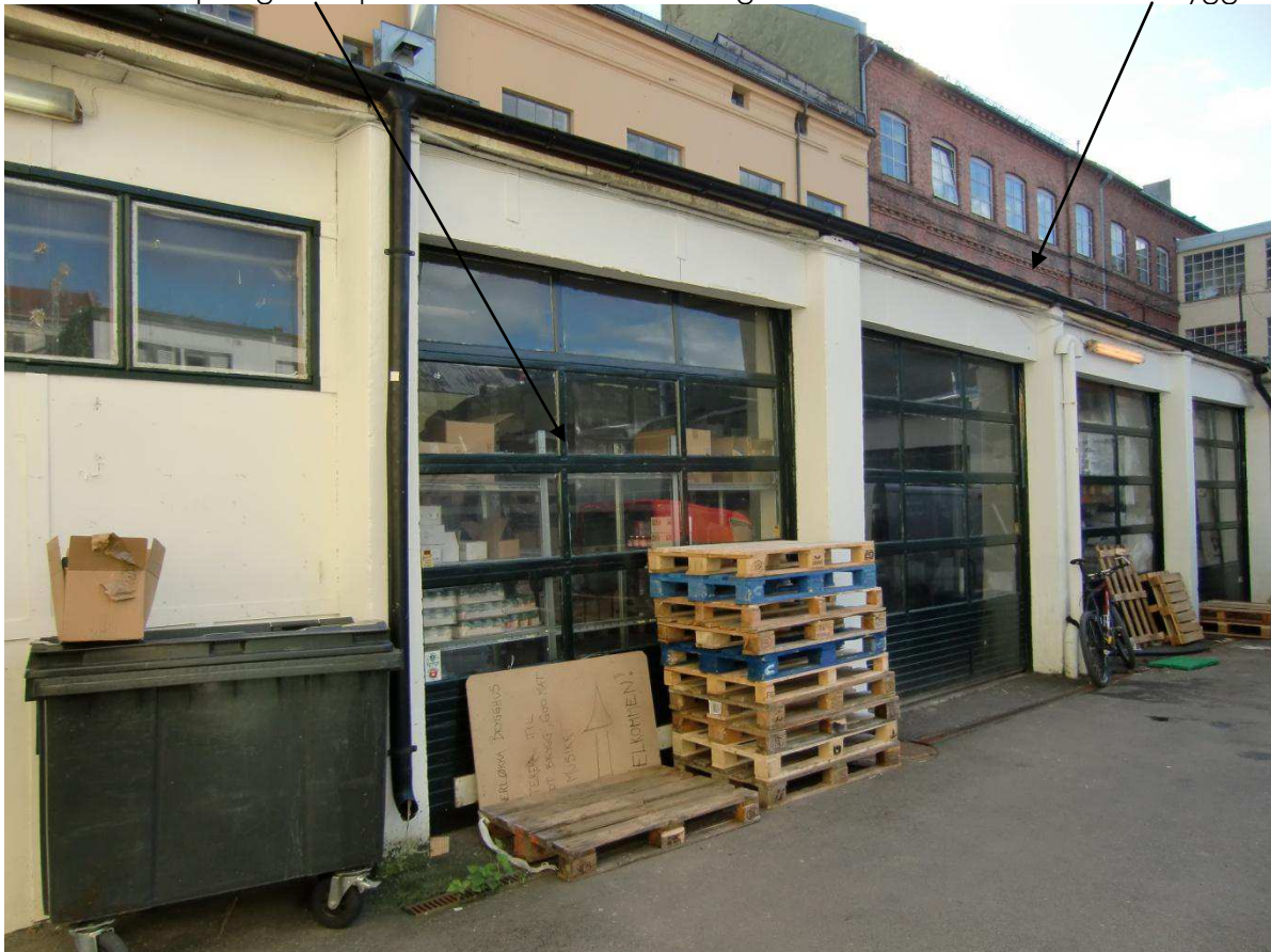
Gårdsrommet og lagerhallen sett inn fra Københavngata.
