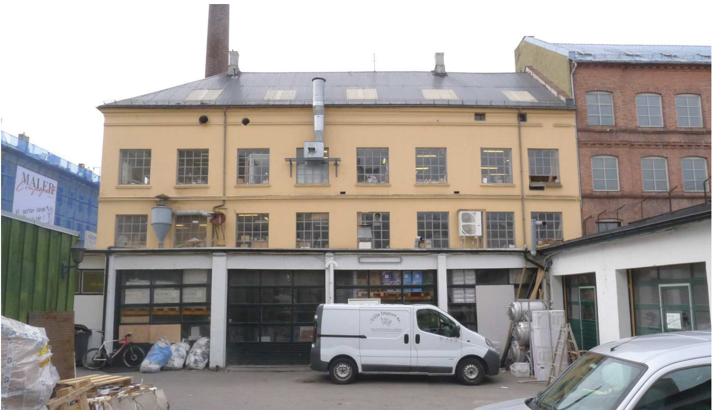
Fasade nord mot bakgård - dagens situasjon
