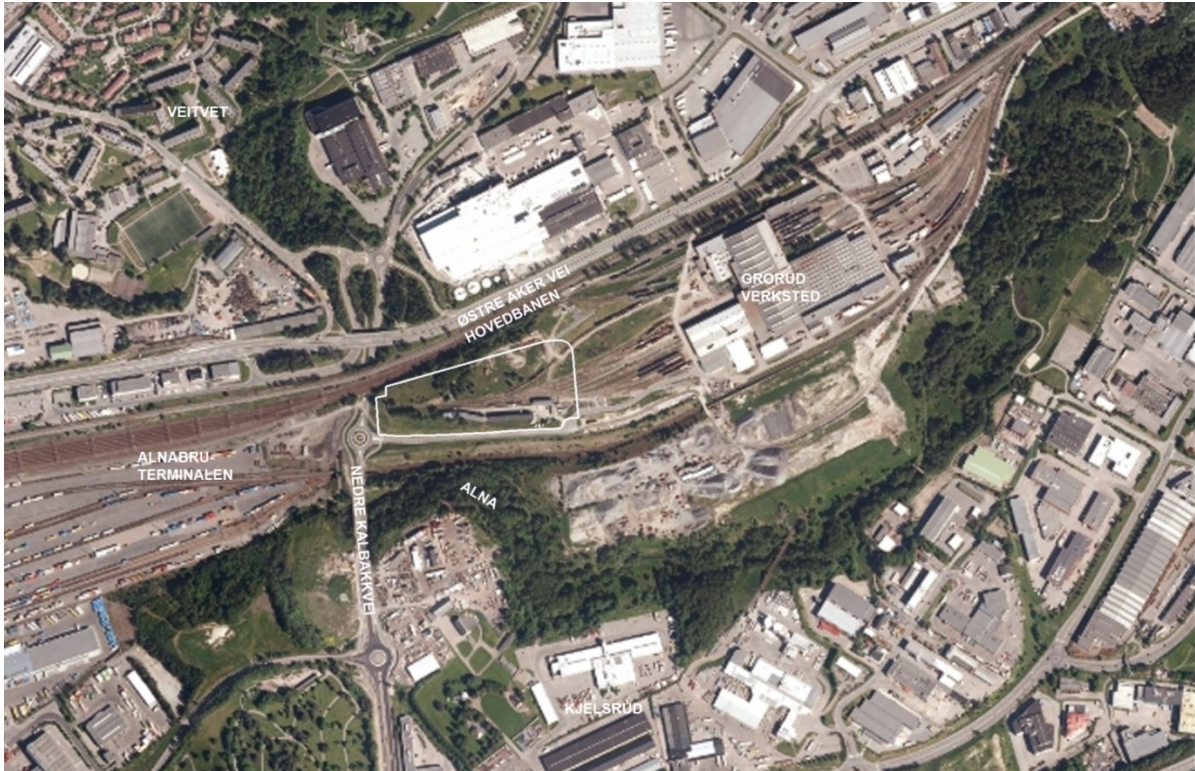
Regjeringen har besluttet at Nasjonalt beredskapssenter for politiet skal etableres på Nyland, mellom Grorud verksted og Nedre Kalbakkvei
