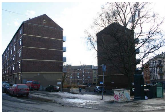
Gavlvegger mot Einar Tambarskjølves plass
