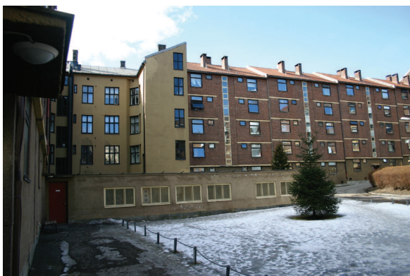
Vaskeribygget i bakgård
