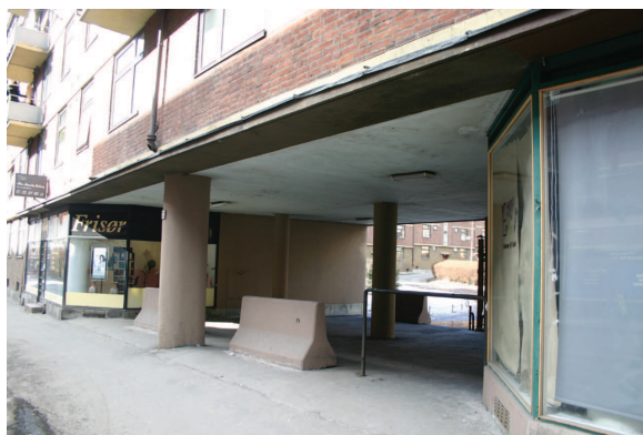
Åpen gjennomgang under Sannergata 32
