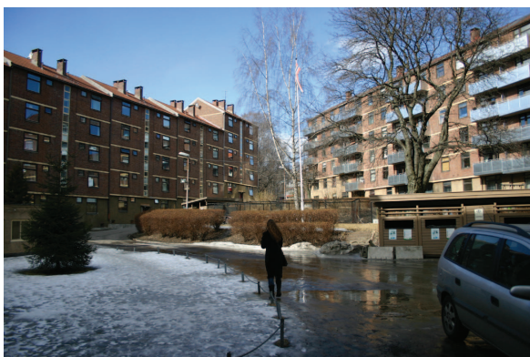
Christies gate 19 og Dælenenggata 40 sett fra bakgård
