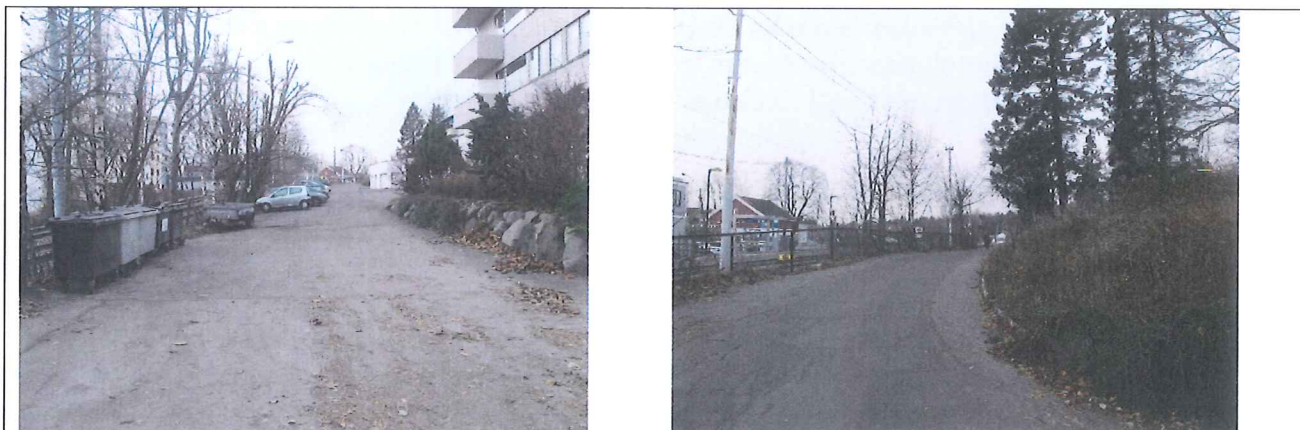
Figur 7: Parkeringsplass og utkjøring for Borettslaget i Lilleakerveien 33
