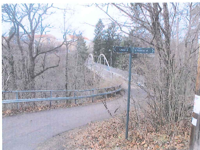
Figur 13: Gangbro over Lysakerelva
