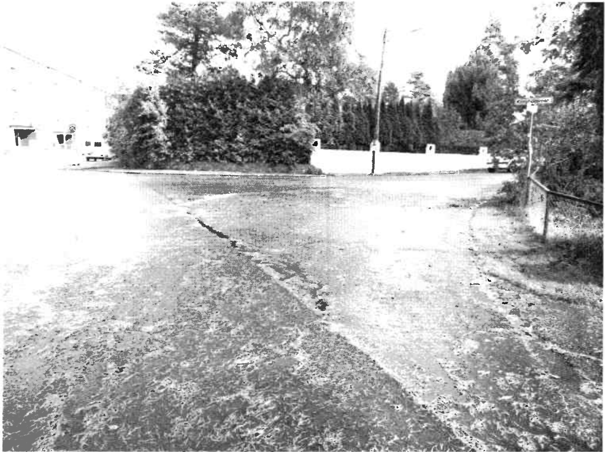
Veikrysset i Bjartveien. Ingen fotgjengerfelt, fartsdumper, fortau eller skoleskilt
