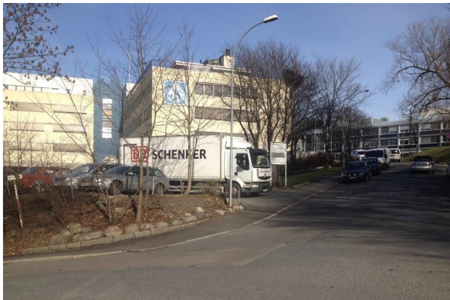
Figur 4 Eksisterende bygning og atkomst, sett fra sør - kryss Stålverksveien x Malerhaugveien.
