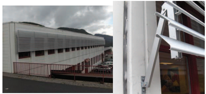
Skole i Flekkefjord: vertikal fast solskjerm i natureloksert aluminium Med C – profil lameller
